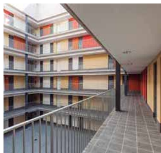
Nowy budynek mieszkalny. 84 mieszkania. Barcelona w Hiszpanii. Aquarea
