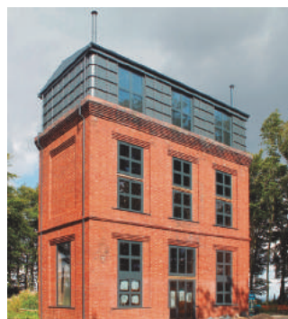
Wieża ciśnieni przebudowana na oryginalny dom jednorodzinny. Yorkshire, Wielka Brytania. AQUAREA
