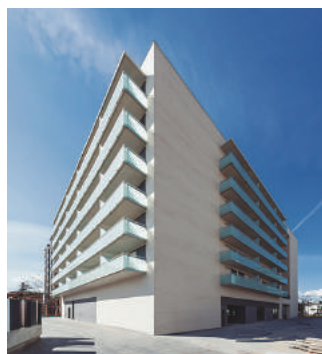
Nowy budynek z 84 apartamentami, zbudowany w dzielnicy Cornella de Llobregat w Barcelonie. AQUAREA
