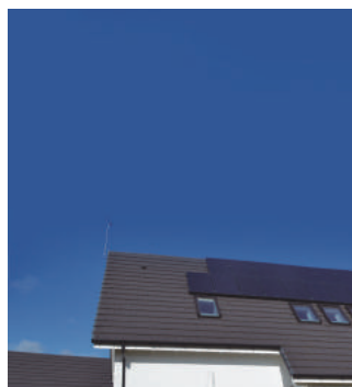
Przykład najlepszego wykorzystania środków z funduszu na rzecz ogrzewania ze źródeł odnawialnych. Średniej wielkości dom bez dostępu do sieci energetycznej. Fife, Szkocja AQUAREA
