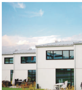
Firma Brabrand Boligforening wybudowała 75 energooszczędnych domów w Hasselager w pobliżu Aarhus. AQUAREA
